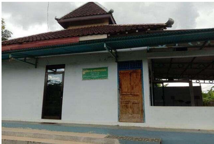
Gambar 1. Kondisi Masjid Al-Mukharomah
